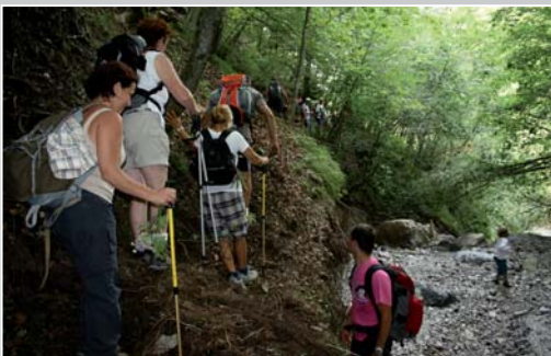
Gita del 30 luglio 2009 (Passo Culmine San Pietro - Desio - Monte Due Mani). Sulla strada del rientro, incontriamo i danni del maltempo che ha colpito la Valsassina nei giorni precedenti.
